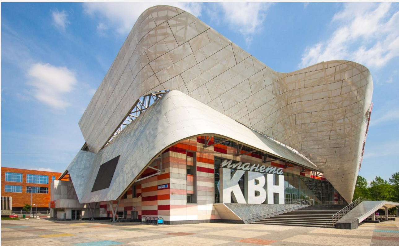
➔ Молодежный центр «Планета КВН» Москва, ул. Шереметьевская, 2 Материал: КраспанФиброцементКолор Подсистема: L-ВСт Краспан Площадь фасада: 4 000 кв.м 2013
